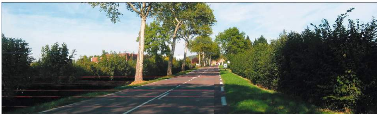
Ph. n° 3 : Une entrée mise en valeur par le jeu de séquences des végétaux : haie bocagère à port libre rythmée par des regroupements d'arbres alignés (3 au premier plan, plus après...).
